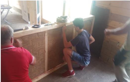
Abbildung 3 – Fixierung des Kupferrohres (mit Moritz Hartmann) an den Lehmsteinen innerhalb der Holzrahmenkonstruktion
