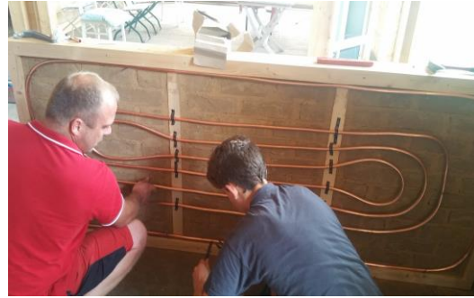
Abbildung 4 – Ausrichtung und Befestigung des Kupferrohres mit Lochband (Alternativmaterial: Kupferband)
