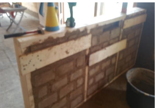
Abbildung 7 – Vollständig ausgemauertes Bauteil, mit dem montierten Kupferrohr inmitten
