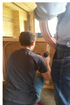
Abbildung 8 – Beim Abrollen des Kupferrohres haben alle Beteiligten mitgeholfen
