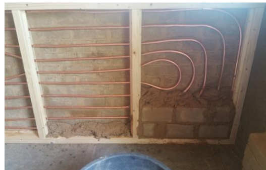
Abbildung 6 – Einsetzen der ersten Lehmstein-Reihe auf den „Rähmbalken“ des Holzrahmens mit Lehmmörtel und vollständiger Verfüllung des Zwischenraumes, wo das Kupferrohr eingebracht ist
